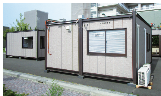
▲病院敷地内に設置された3棟のプレハブ（奥：受付、左：待合室、手前：発熱外来）
